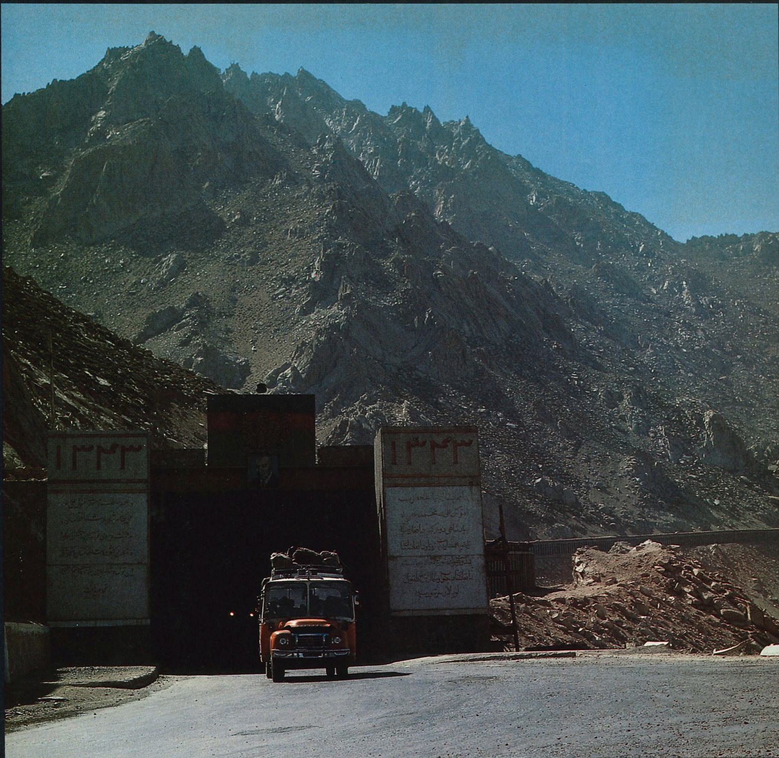
Das Südportal des Salang-Tunnels, der auf 3337 Metern Höhe Nord- und Südafghanistan verbindet. Tunnel und Passstrasse wurden zwischen 1957 und 1964 von den Russen gebaut – mit Hintergedanken, wie sich 1979 erweisen sollte
